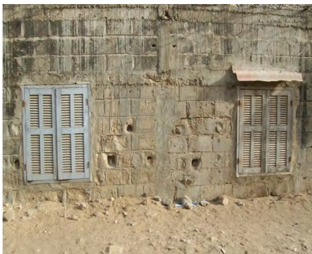
Photo 24 : des fenêtres presque à sol à Dalifort du fait des remblais
