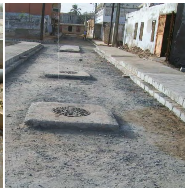
Photo 35 : réseau de collecte des eaux pluviales à Cité Soleil
