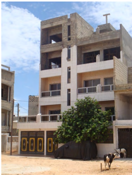
Photo 21 : Maison R+2 en surélévation de deux étages à la cité Hamo 6
