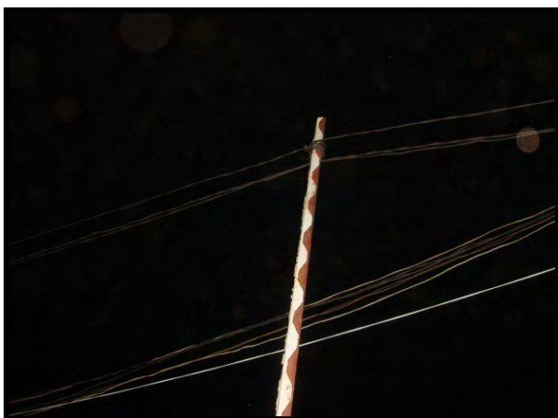
Photo 22: fils attachés au bois Nafadji
