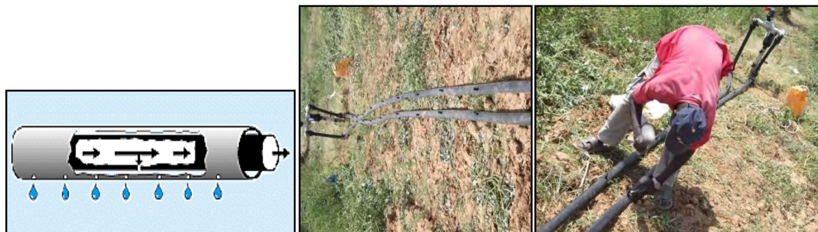
Source linéaire d'irrigation au goutte-à-goutte munie de perforations peu espacées; Photo 8 : installation du goutte à goutte au centre Saane de Bakel par l'ONG Enda Lead Francophone
