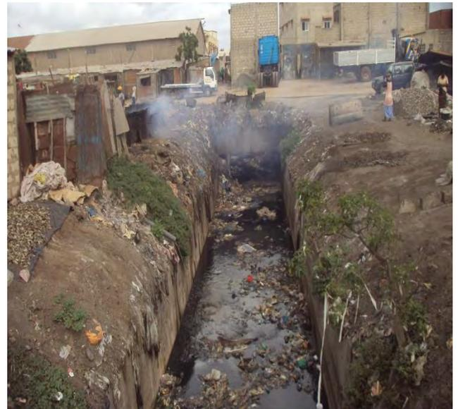
Photo 7 : Déversement d'ordures ménagères dans le canal VI bis
