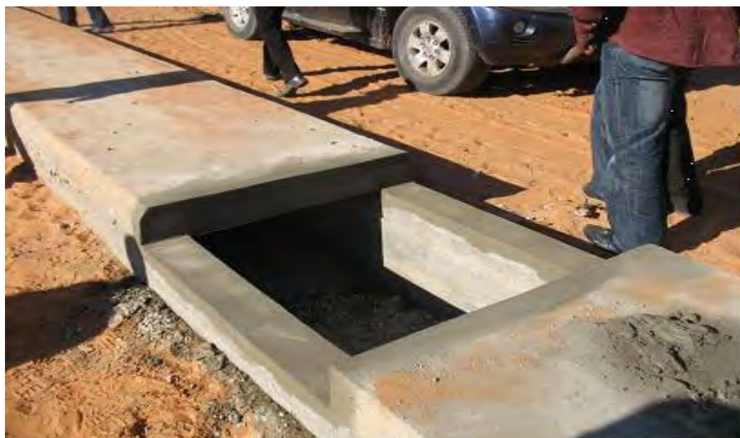
Image 9 : Une section de caniveau en finition
