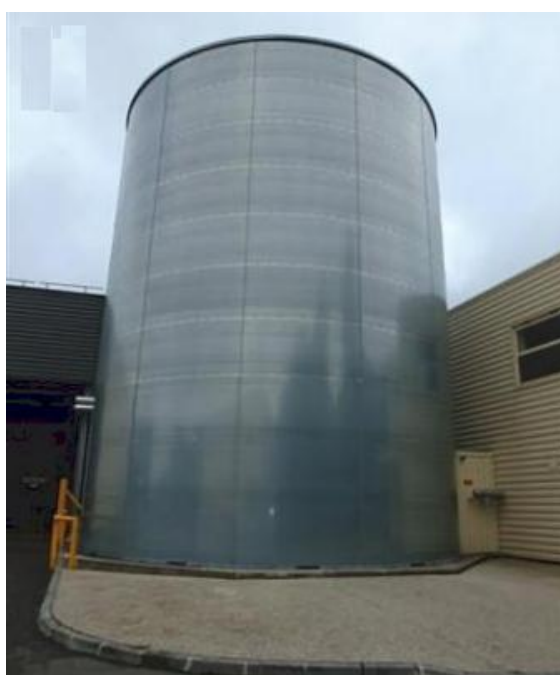
Figure III. 14: Réserve d'eau aérienne
