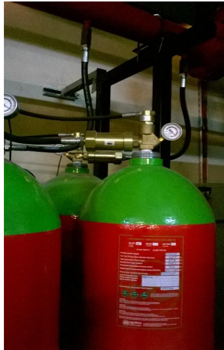
Figure IV : 1: Bouteille de gaz IG55
