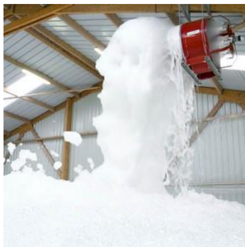
Figure III. 22: Mousse à haut foisonnement
