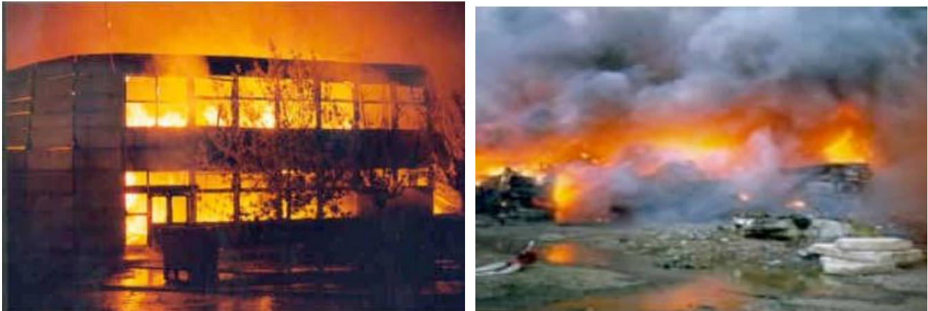
Figure I. 9: Conséquences d'un incendie sur un bâtiment
