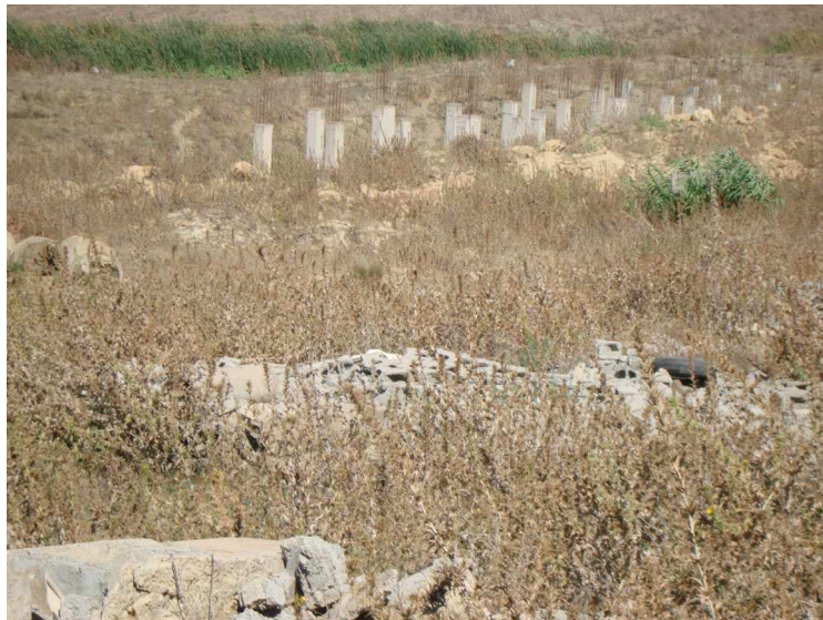
Photo 15 : Construction illicite à l'arrêt.
