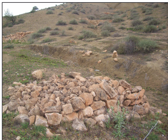
Photo n°22 : reprise de l'érosion régressive entre deux seuils (Cliché Zékri et Boucif, Avril 2011)
