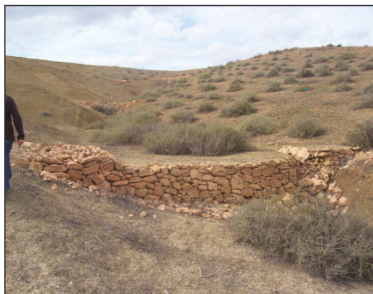
Photo n° 19: atterrissement des terres transportées à 100% à l'amont du seuil (Cliché Zékri et Boucif, Avril 2011)
