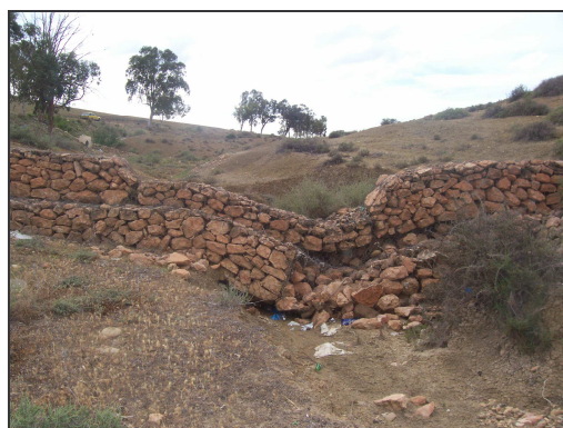
Photo n° 14 : seuil en pierres sèches détruit dans sa partie centrale et reprise de l'érosion régressive (Cliché Zékri et Boucif, Avril 2011)
