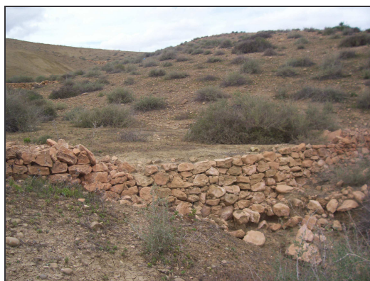
Photo n° 15 : déversoir surdimensionné (Cliché Zékri et Boucif, Avril 2011)
