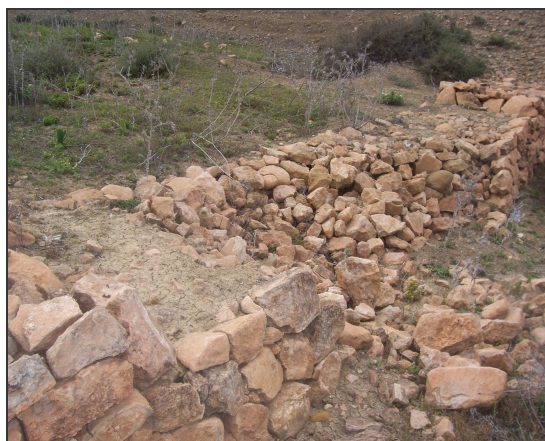
Photo n°20 : seuil submergé par la terre transportée (Cliché Zékri et Boucif, Avril 2011)
