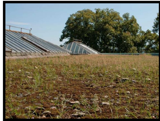
Photo 5 : Toitures végétalisées spontanées : végétation peu dense mais très couvrante, structure homogène
