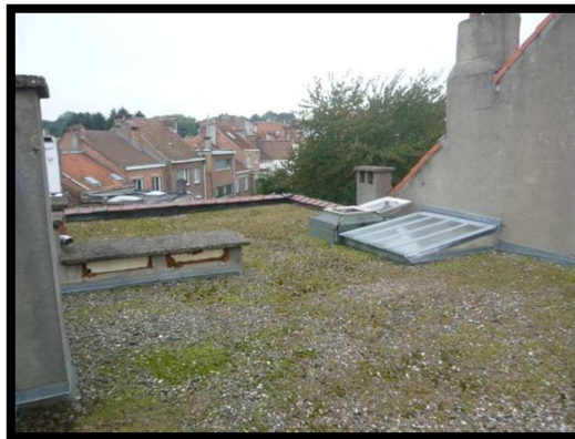
Photo 3 : Toitures végétalisées spontanées partielles : végétation très éparse (patch de végétation), structure homogène
