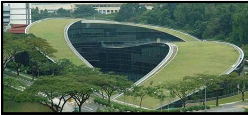
Photo 2 : Toitures végétalisées semi-intensives : végétation dense rase, structure très homogène
