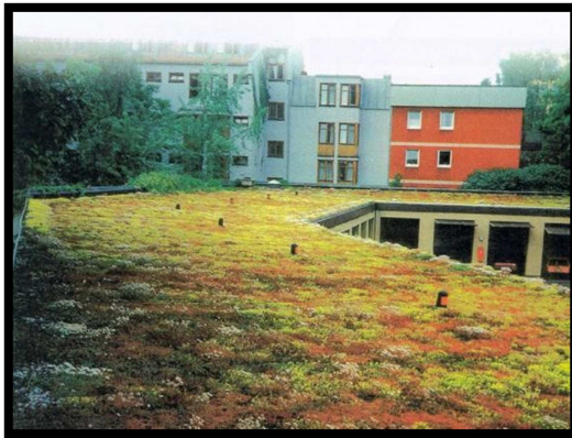
Photo 4 : Toitures végétalisées extensives : végétation assez dense, très couvrante et structure homogène (verdure moins éclatante)
