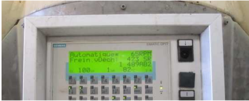
Photo 2 : Ecran de contrôle des paramètres d'essoreuse
