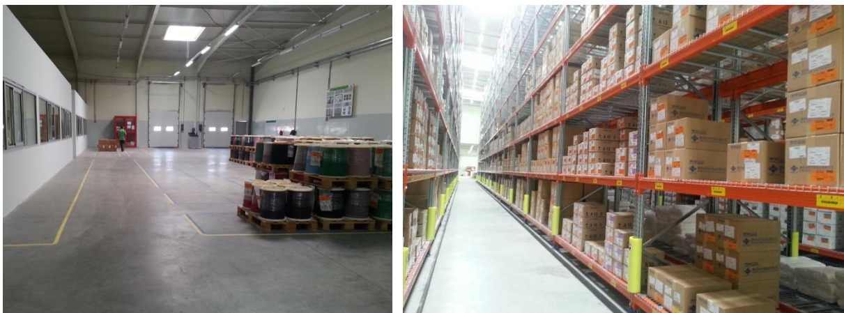
Figure 9 Zone réception – Magasin matières premières
