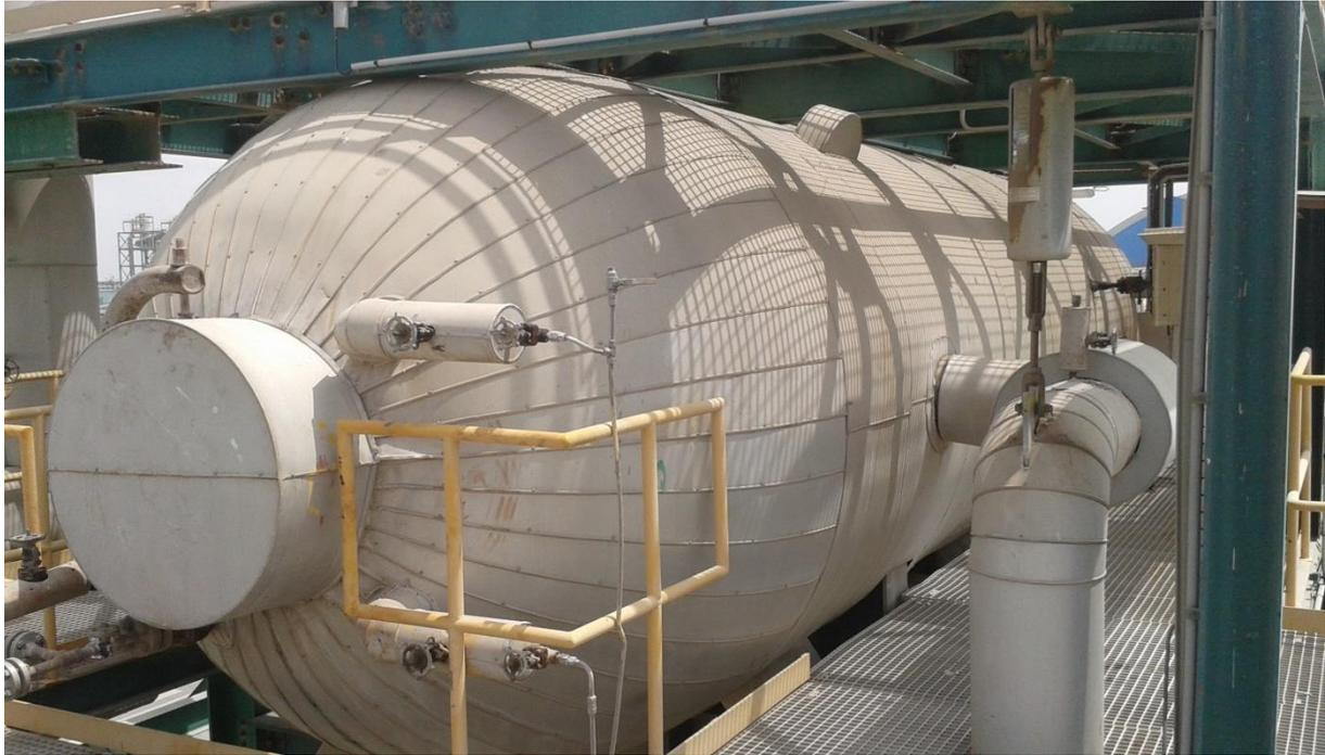
Figure I-2.3 Ballon de chaudière
