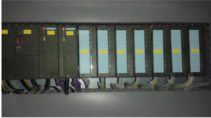
Figure I-2.7 Station de périphérie décentralisée ET200M
