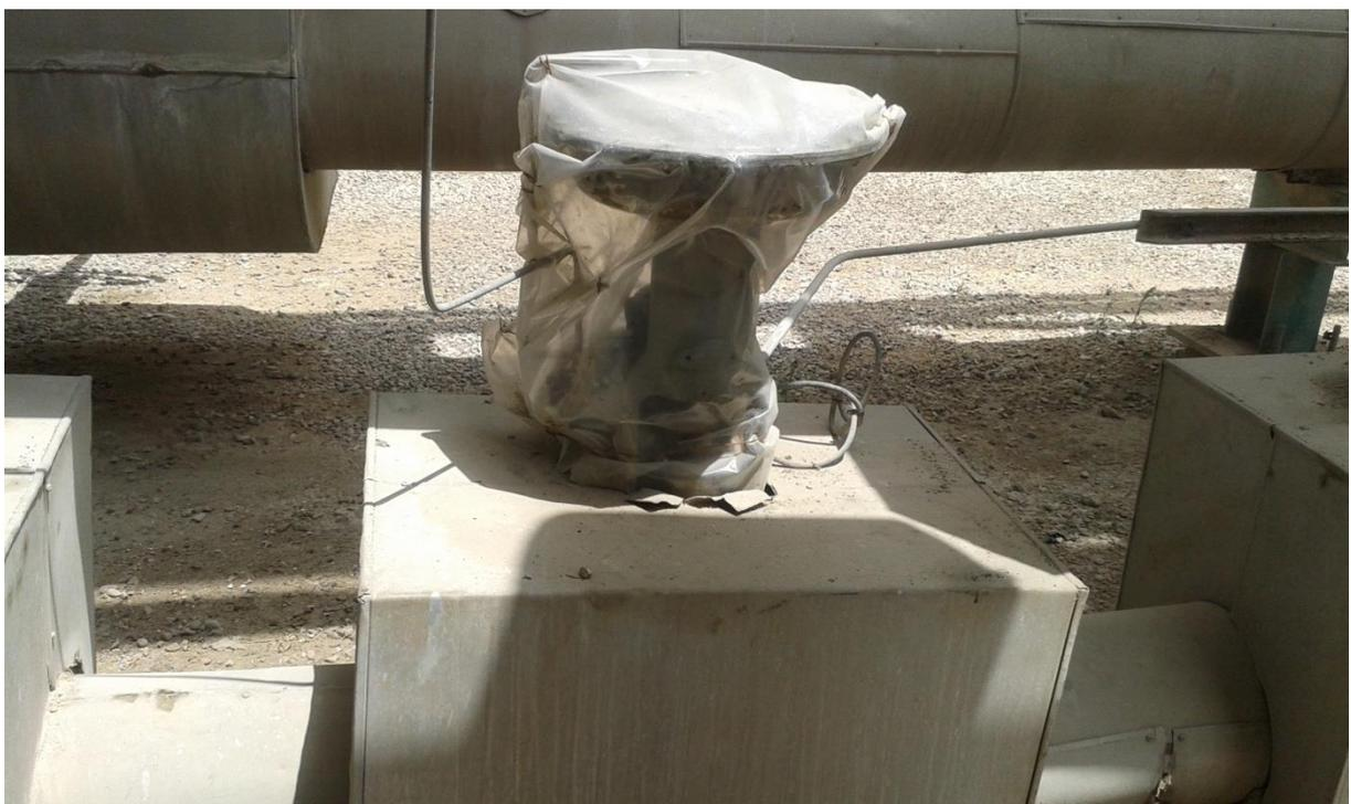
Vanne régulatrice de débit de l'eau d'alimentation de du ballon de la chaudière
