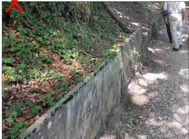
*Ne sont à relever que les ouvrages de stabilisation d'une fonction importante. Sur l'exemple de gauche, la disparition de l'ouvrage entrainerait l'impraticabilité du chemin adjacent. L'ouvrage est donc à relever. Sur l'exemple de droite, la fonctionnalité du chemin ne pourrait être remise en cause suite à la disparition de l'ouvrage, ce dernier n'est donc pas à relever.*
