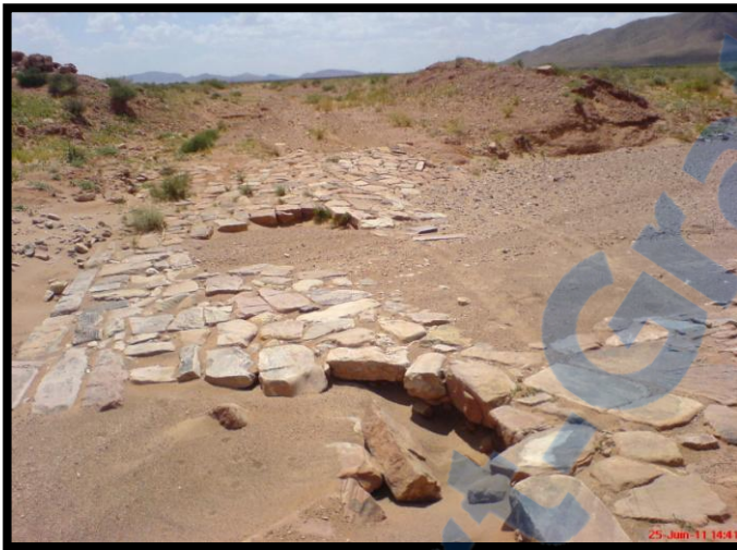
Photo n°27 : Destruction et envasement total d'un seuil
