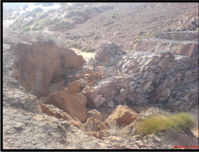
Photo n°25 et 26 : Seuil en gabion emportée par les eaux des pluies
