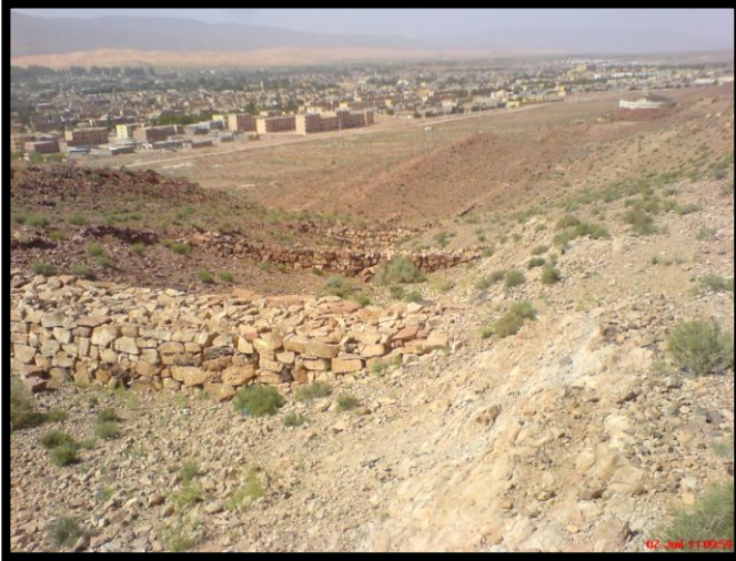
Photo n°7 et 8 : Les seuils en pierre sèche
