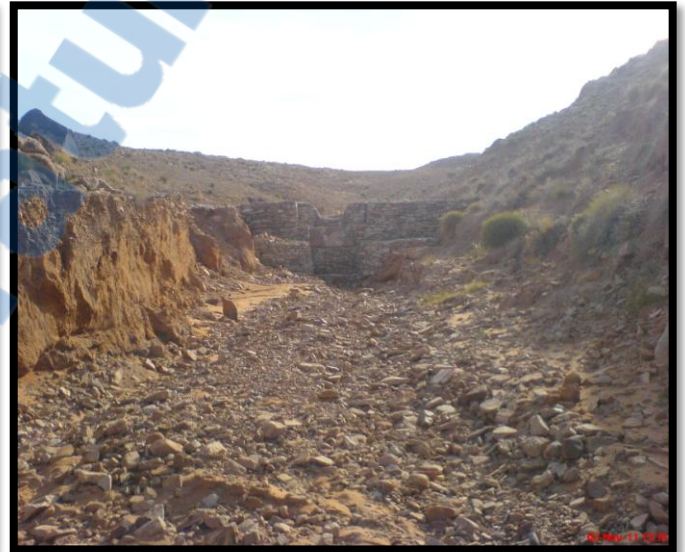
Photo n° 9 et 10 : Les seuils en gabion utilisés dans la fixation des ravines
