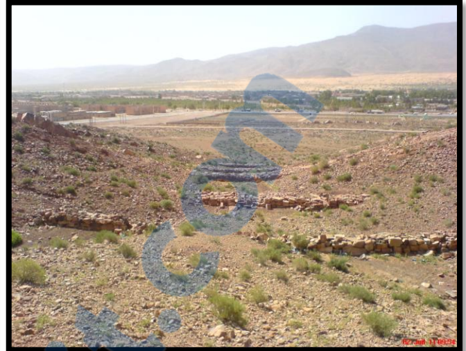
Photo n°7 et 8 : Les seuils en pierre sèche
