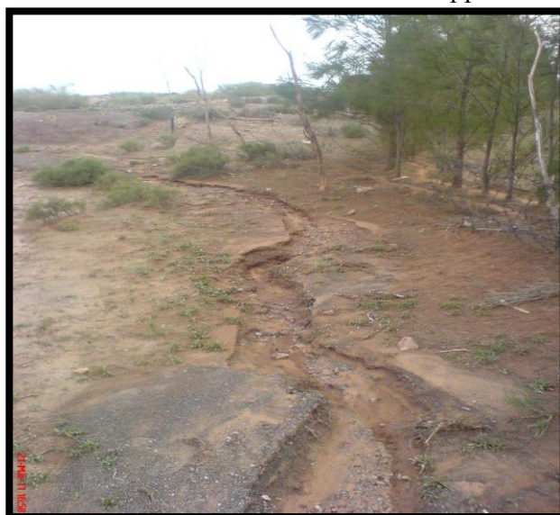
Photo n°3 L'érosion en rigole
