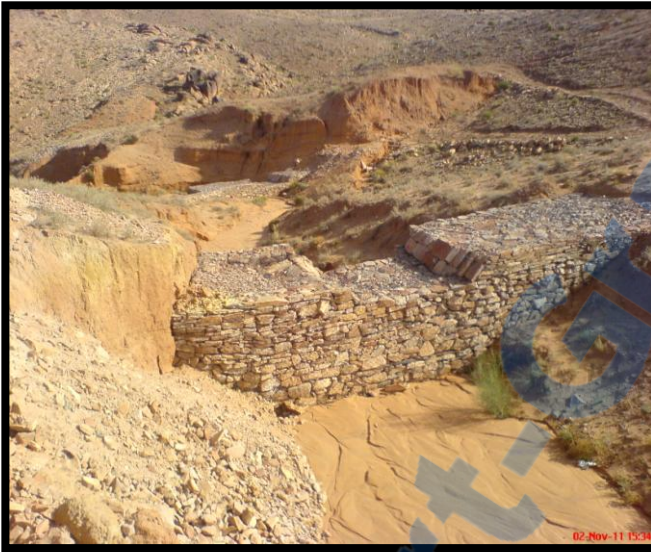
Photo n° 9 et 10 : Les seuils en gabion utilisés dans la fixation des ravines
