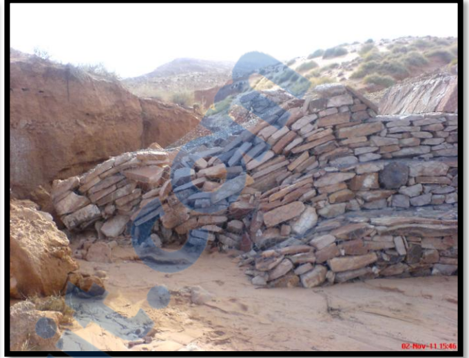
Photo n°25 et 26 : Seuil en gabion emportée par les eaux des pluies
