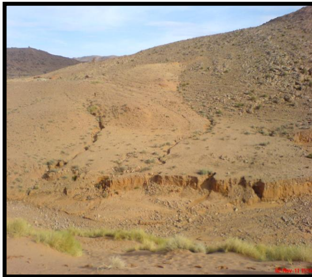
Photo n°2 L'érosion en griffe
