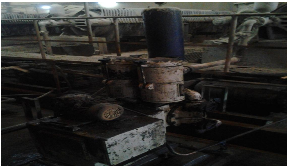
Fig IV.1 pompe à membrane
