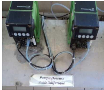
Figure 15 : Pompes doseuses d'acide sulfurique
