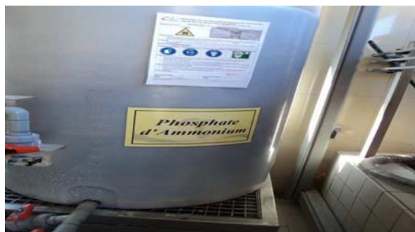
Figure 17 : conteneur du phosphate d'ammonium
