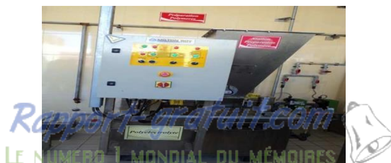
Figure 18 : station de préparation du polymère
