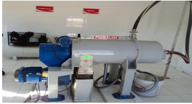
Figure 12: centrifugeuse des boues
