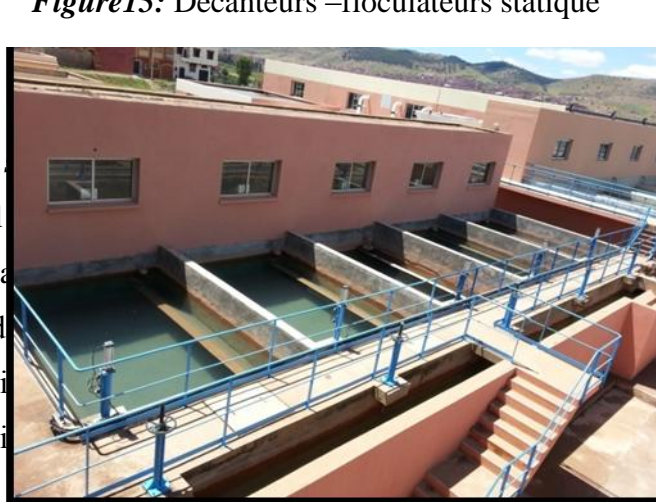
Figure15: Décanteurs –floculateurs statique
