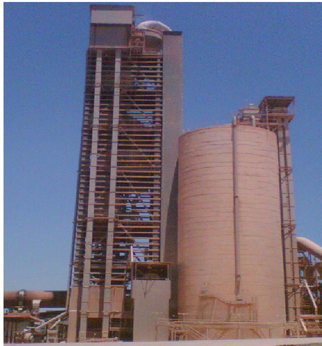
Figure 11: Silo farine et la tour de préchauffage
