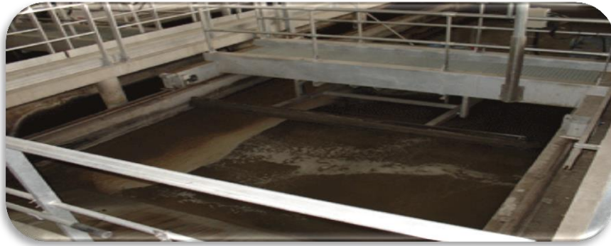
Photo 3 : Opération de dessablage dans la station de prétraitement.
