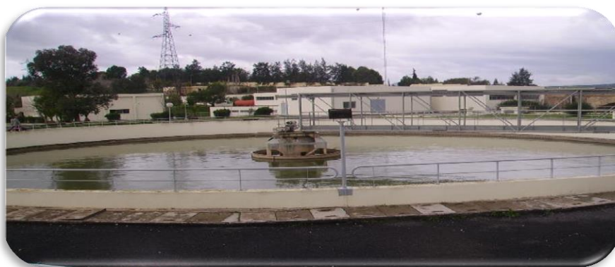
Photo 4 : Opération de débouillage dans la station de prétraitement
