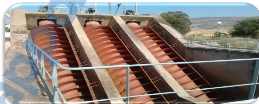
Photo 2 : Opération de relevage dans la station de prétraitement
