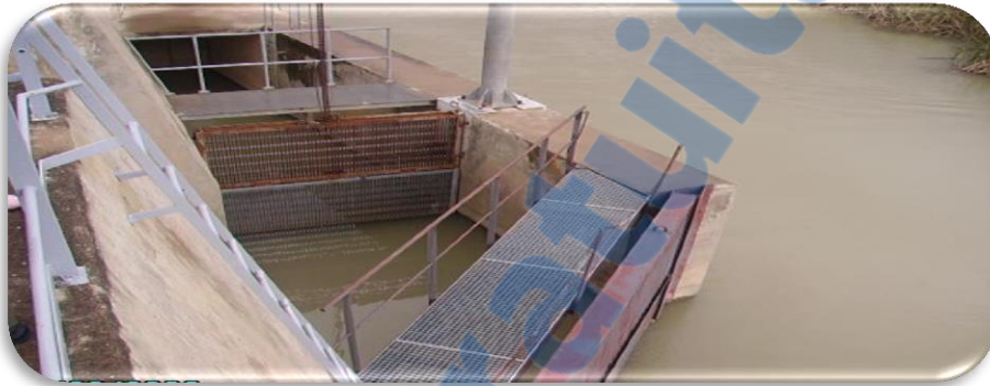
Photo 1 : Opération de dégrillage dans la station de prétraitement
