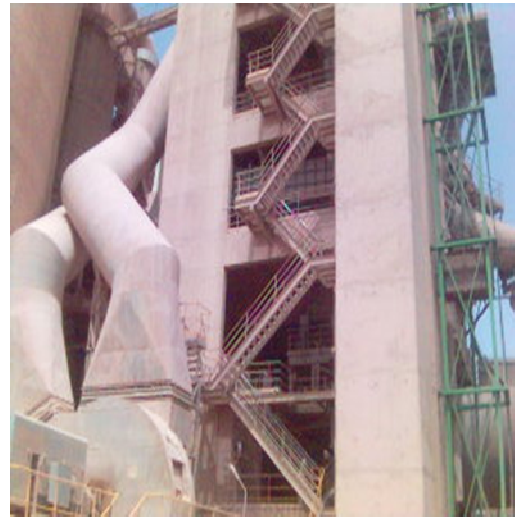
Figure 9: Préchauffeur a cyclones avec précalcinateur pour l'alimentation du four.
