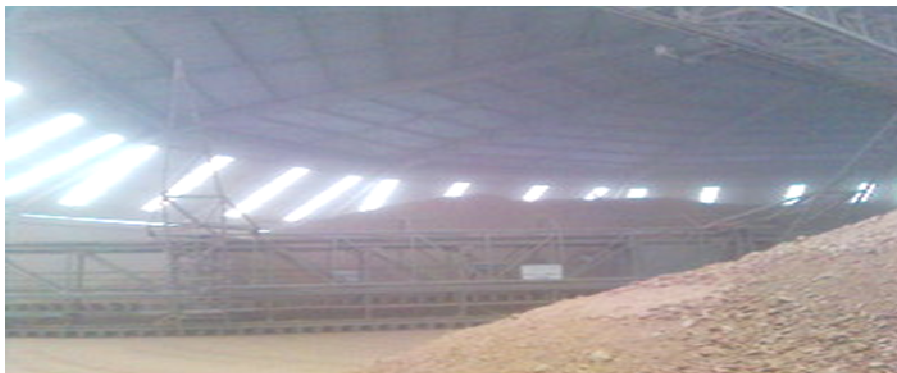
Figure 7 : hall de pré-homogénéisation
