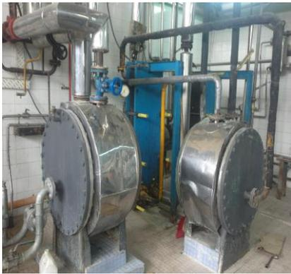
**Figure 9** : Echangeurs Tubulaires
