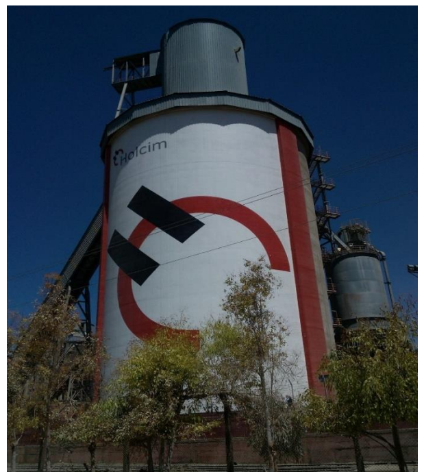
Figure 5 Silo à Clinker
