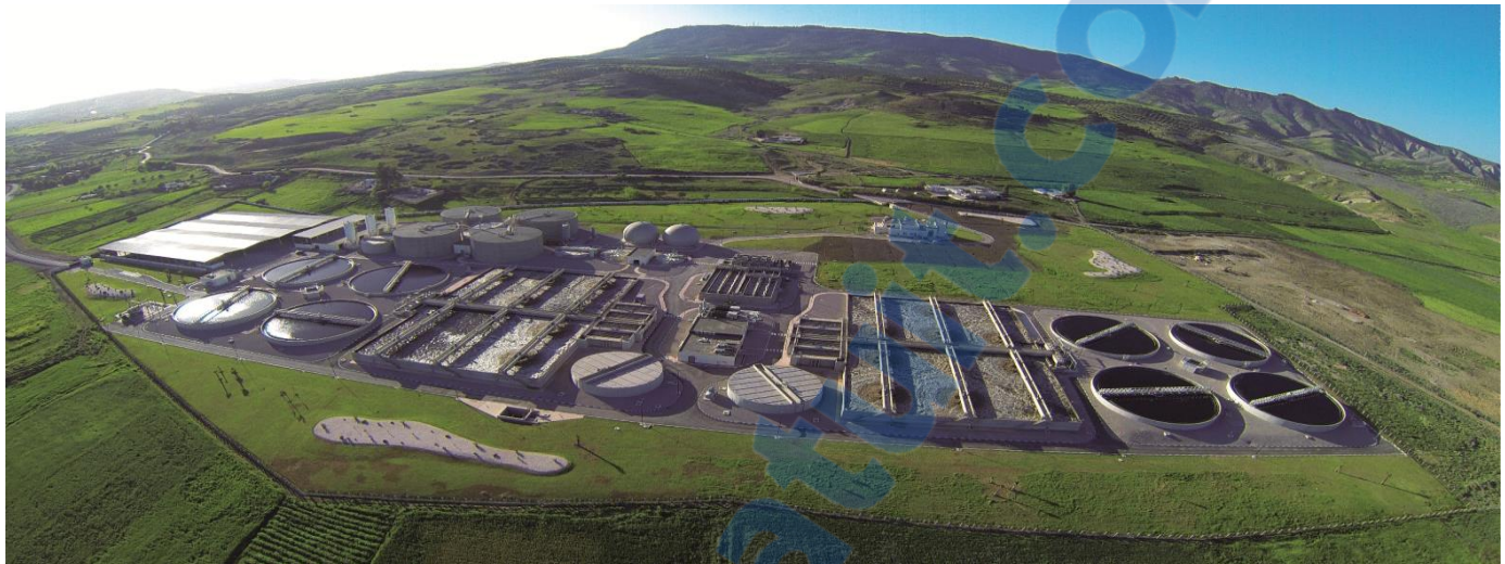
Figure 1 : Vue générale de la station d'épuration des eaux usées de Fès
