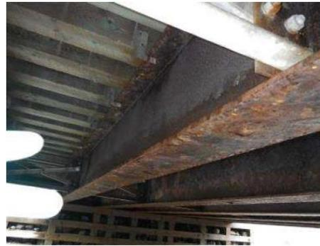
(b) Corrosion d'une poutre en acier
