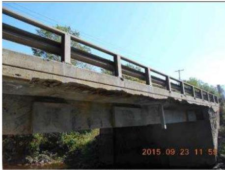
(a) Fissuration, désagrégation du béton et corrosion de l'acier d'armature
