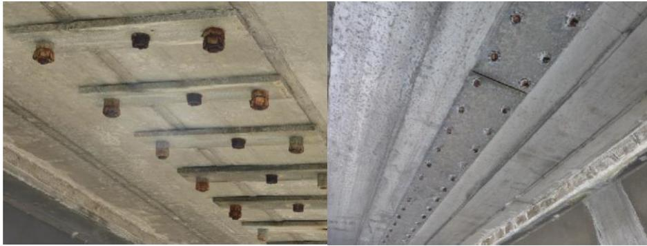
Figure 2-11 – Corrosion des boulons galvanisés du pont de Little Buffalo Creek (Beaulieu et al., 2015)
