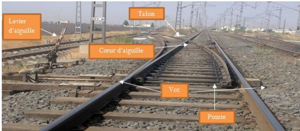
Figure 12 : Différents composants de l'aiguille.
