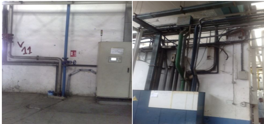
Figure 5.8: les conduites souterraines
