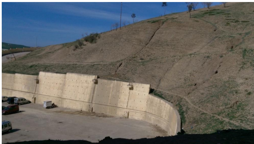
Figure 59 : Mur de soutènement
