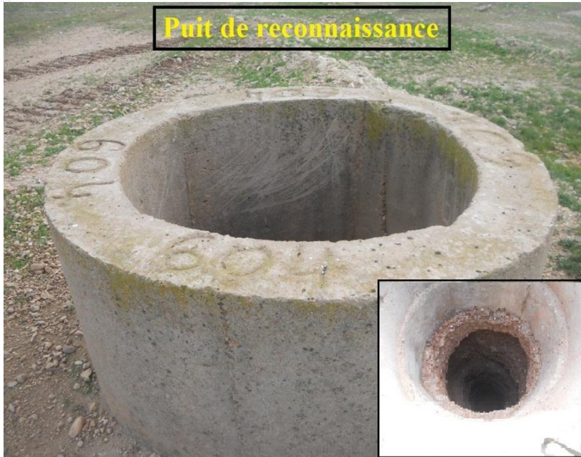
Figure .II.2 : Puits de reconnaissance et de prospection
