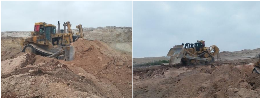
Photos 13 : Engins D11 pendant le décapage
