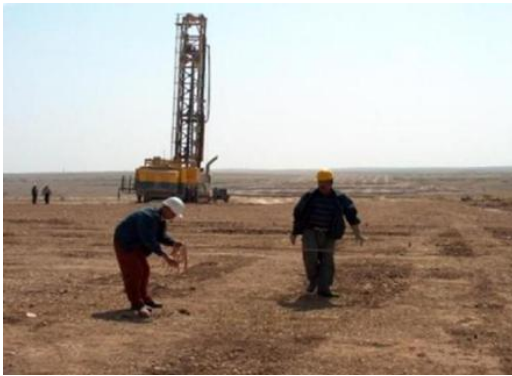
Photo 5 : Implantation des limites par les géomètres
