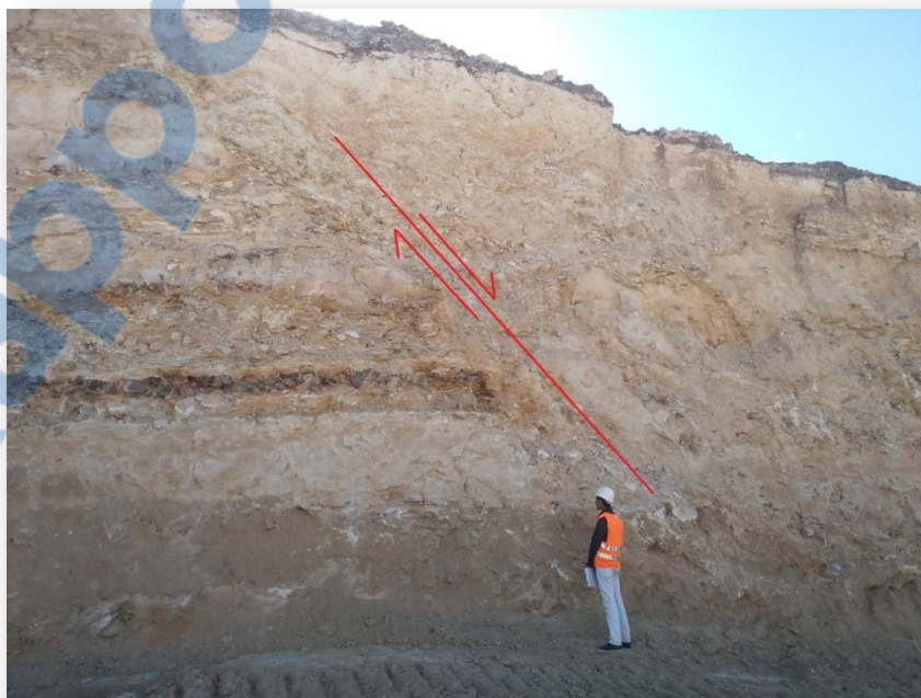
Figure 10 : Une faille normale qui affecte la série phosphatée
