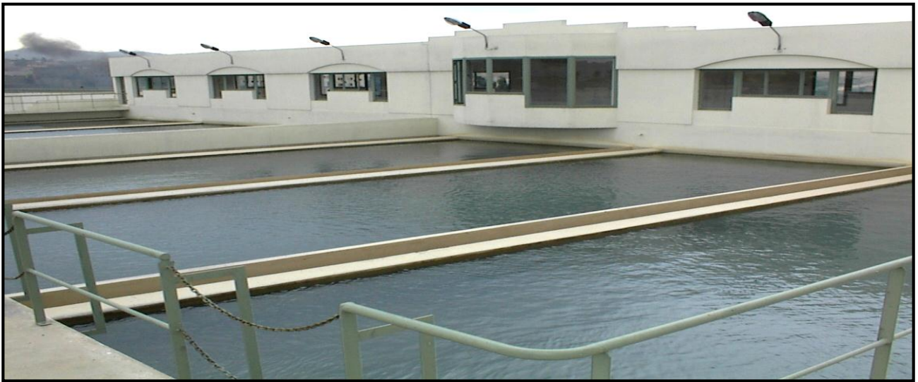
Figure 6. photo des filtres à sable prise dans la station de traitement
