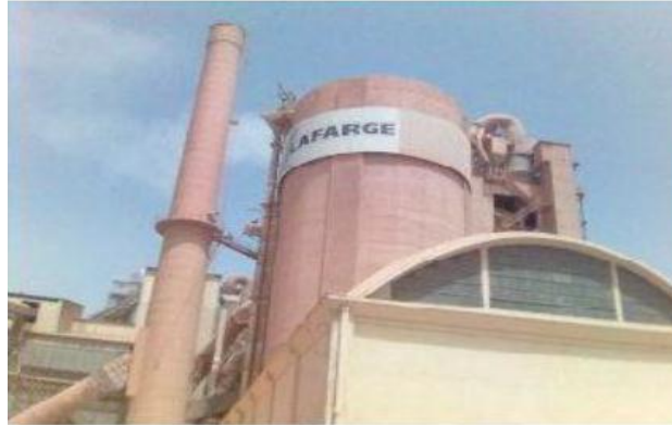
Figure 10 :: Silos d'homogénéisation
