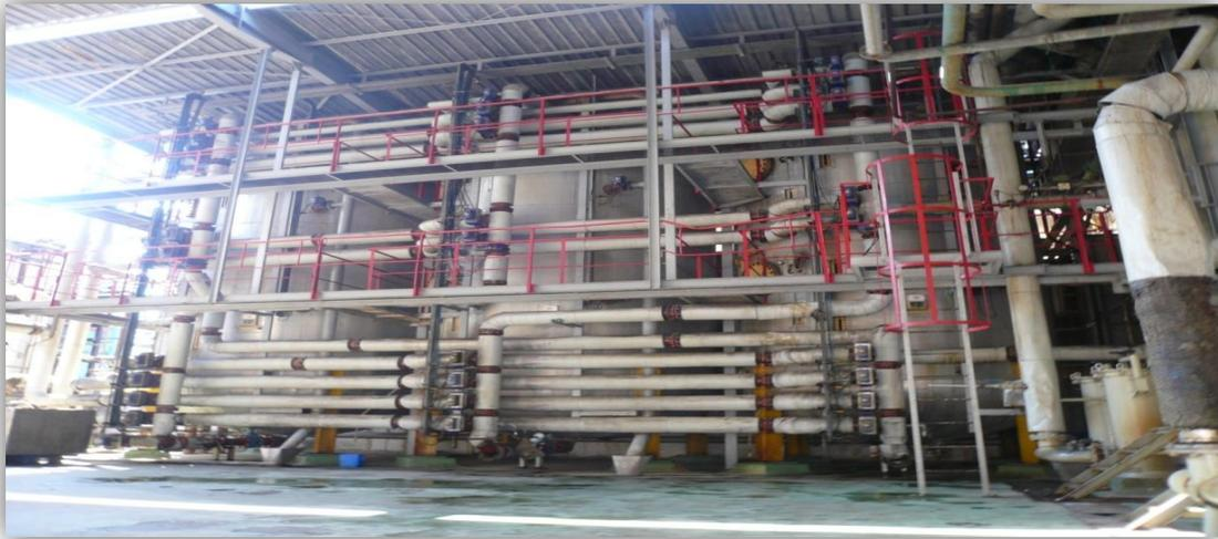
Figure 5 : Image des trois colonnes de la station 110 m<sup>3</sup>/h.
