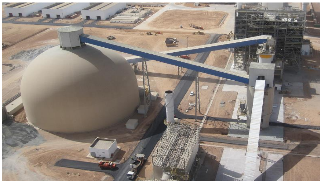
Figure 21: Le Dôme du stockage Clinker.
