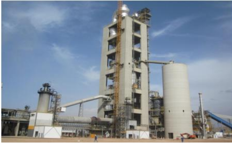
Figure 17: préchauffeur.
