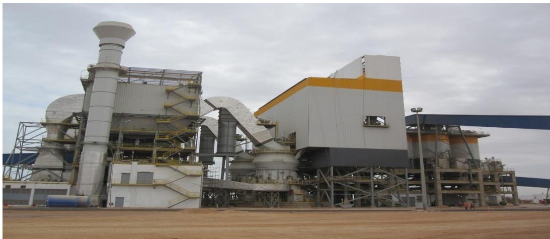
Figure 24 : Atelier de broyage Ciment.
