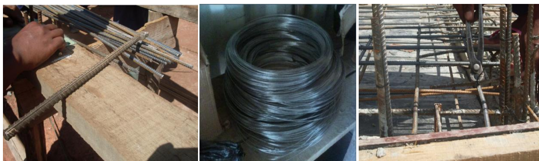
Façonnage de l'armature
