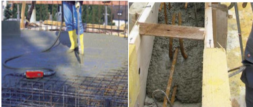
Vibration du béton de la dalle
