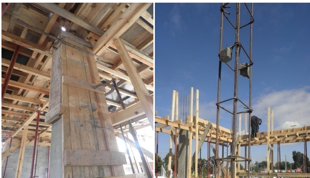
Coffrage entre poteau et dalle
