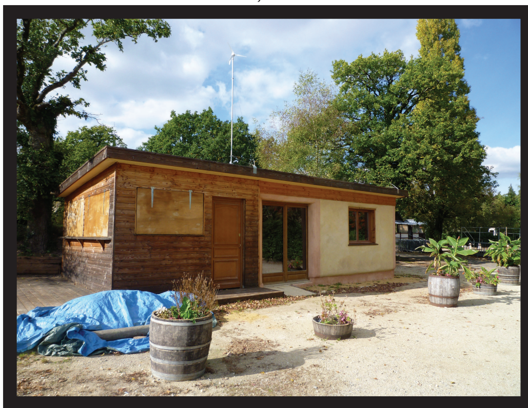
PHOTO N°2 : LE PROJET ECO-CONSTRUCTION
