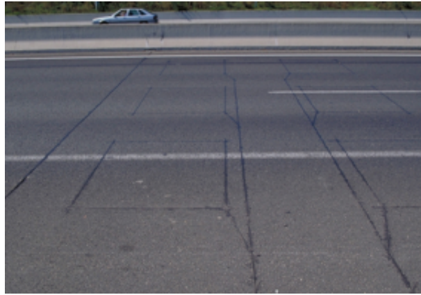
Fig. 3.2.: Boucles électromagnétiques sous la chaussée - Source : transport-intelligent.net
