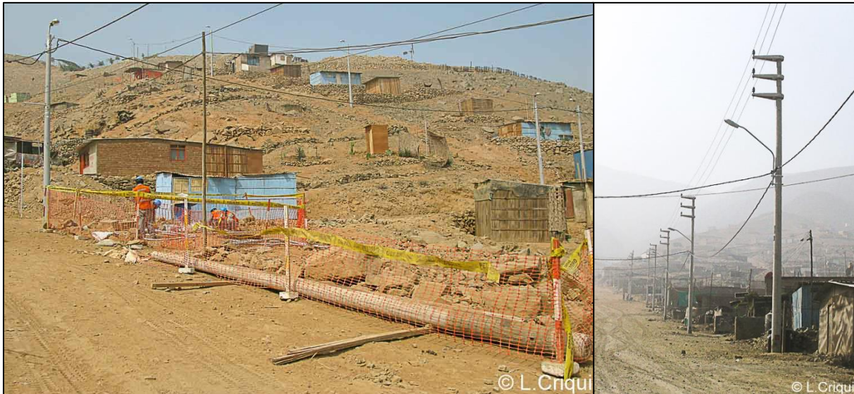
Photo 97/L. Électrification avant construction complète
