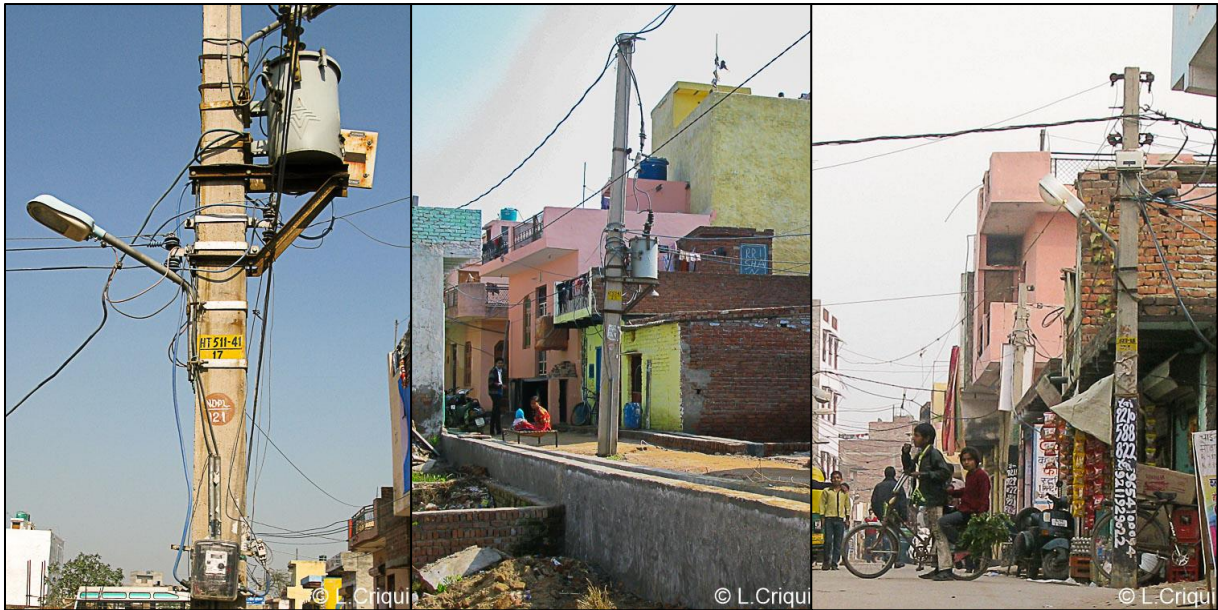
Photo 81/D. Transformateur sur bras
