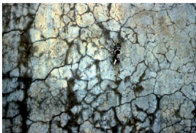
Figure I-23 : Réseau de fissures d'un mur en aile affecté par la RAS (Godart et al.2008)
