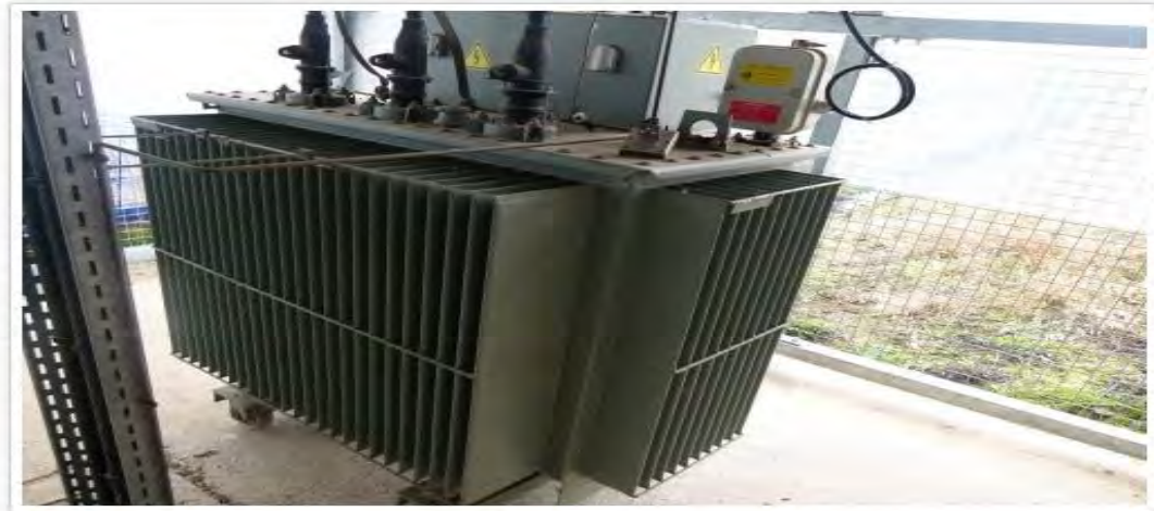
Figure 14: transformateur élévateur de 400\text{V} à 30000\text{V}
