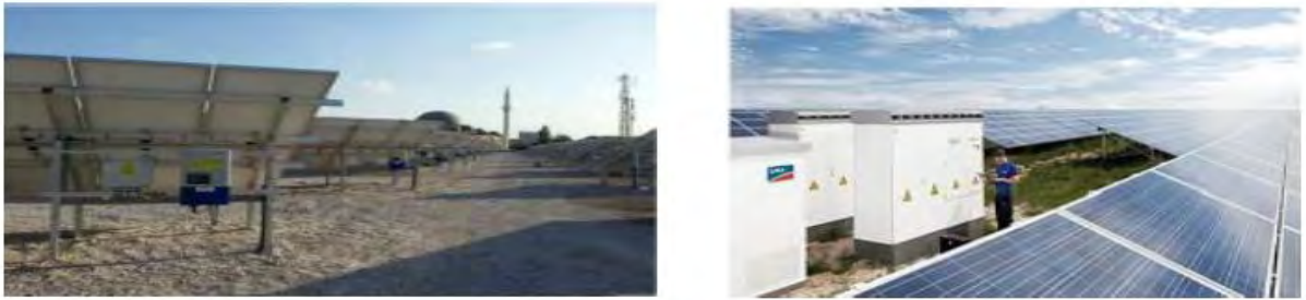
Figure 2: configuration 1, onduleurs décentralisés et configuration 2, onduleurs centraux [4]
