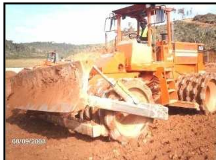
Figure 25: Photo couches de remblai scarifié
