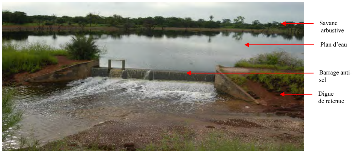
Planche 2 : Barrage anti- sel de Senghor et digue de retenue d'eau en octobre 2008
