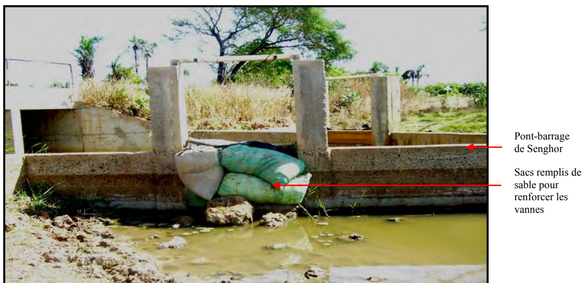
Planche 3 : Etat du micro-ouvrage hydraulique de Senghor
