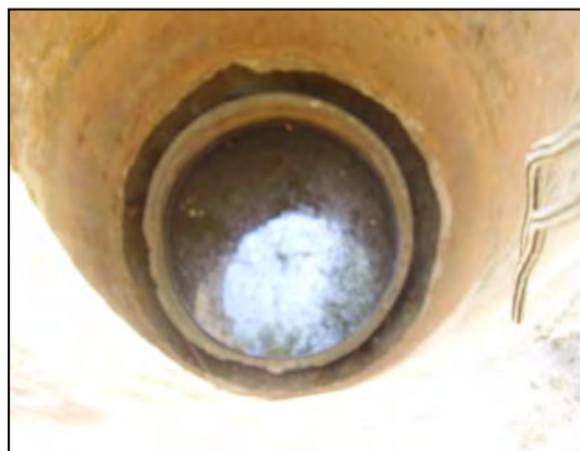
Planche 8 : Puits abandonné par intrusion saline
