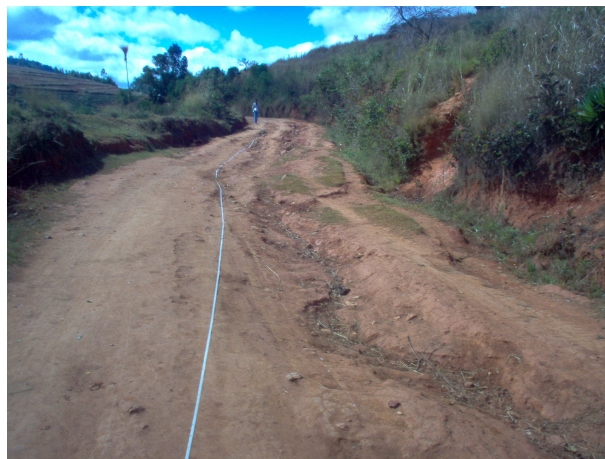
Demi-chaussée dégradée par des ravinelements
