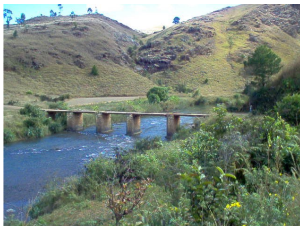
Pont en Platelage en bois de 42 ml à Vatomarirana PK 7+650
