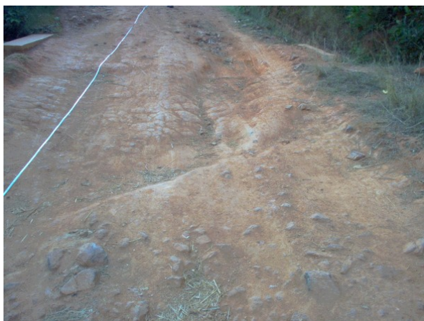
Chaussée dégradée par des ravine- ments longitudinaux
