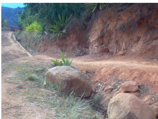
Fossé bouche par des blocs rocheux
