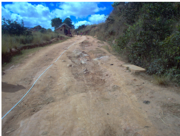
Chaussée dégradée par des ravinelements profonds
