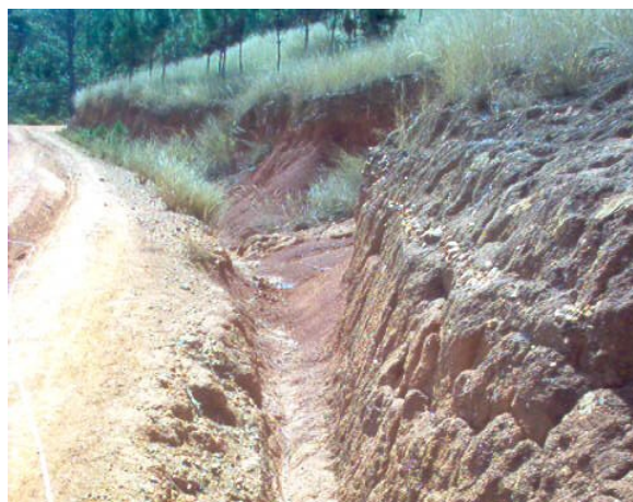
Type de dégradation de fossé sur descente Vatomarirana
