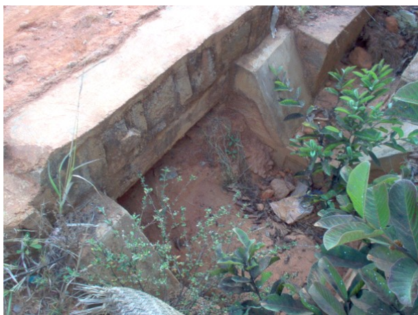
Dalot bouché et non fonctionnel
