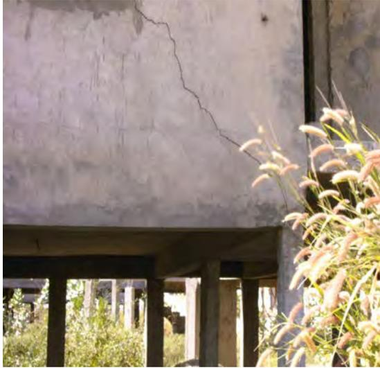
Photo 18 : Bâtiments sur pieux fracturés et effondrés
