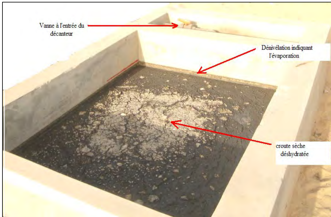
Photo 7 : Croute de flottants au niveau de la première cloison
