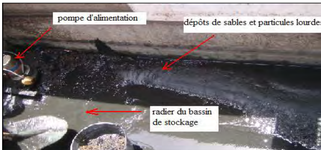
Photo 5 : zones de dépôts de sables et de matières solides lourdes dans le bassin de stockage
