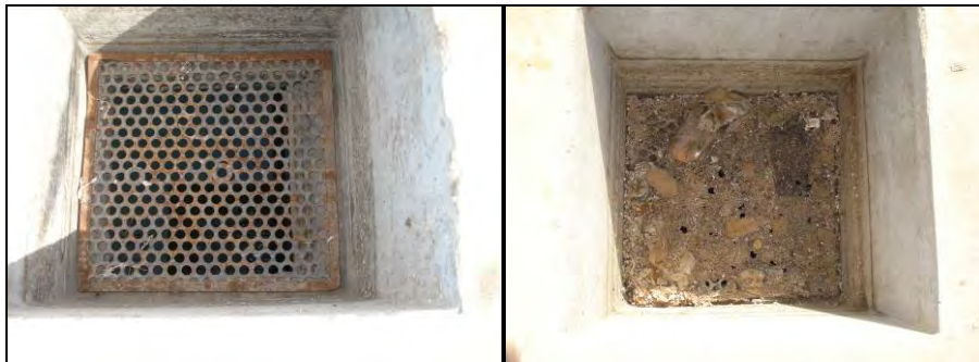
Photo 3 : Grille du bassin de stockage avant et après un dépotage
