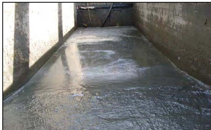
Photo 8 : Boues épaissies au fond du décanteur
