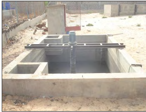
Photo 1 : Bassin de stockage et hélices de l'agitateur
