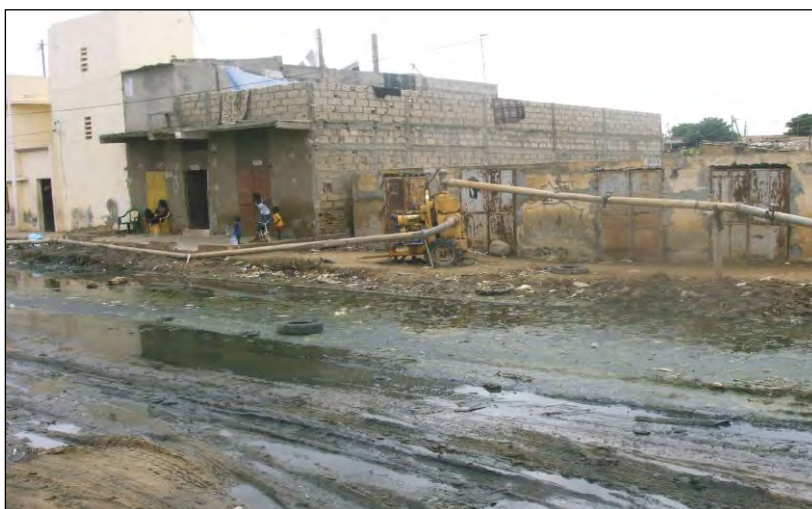
Figure12: Opération de pompage des eaux à Gounass 1
