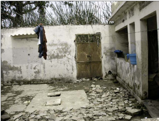
Photo 6 : Construction dégradée à cause de l'humidité, du sel et du développement racinaire des végétaux. Dans cette maison la fosse(dans la cour) est complètement endommagée (2005).
