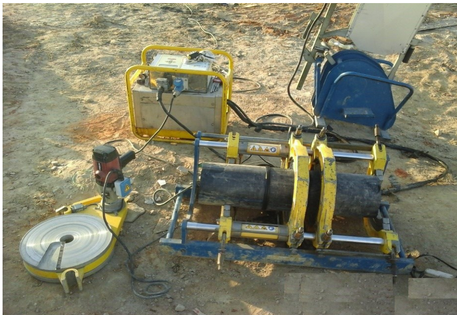
Figure. 2.1 : Opération de soudage b-à-b sur chantier
