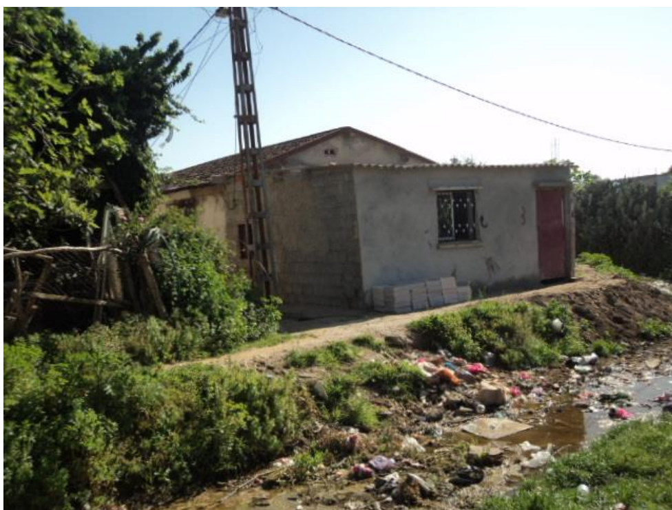
Figure 22 : Extension sommaire de la maison
