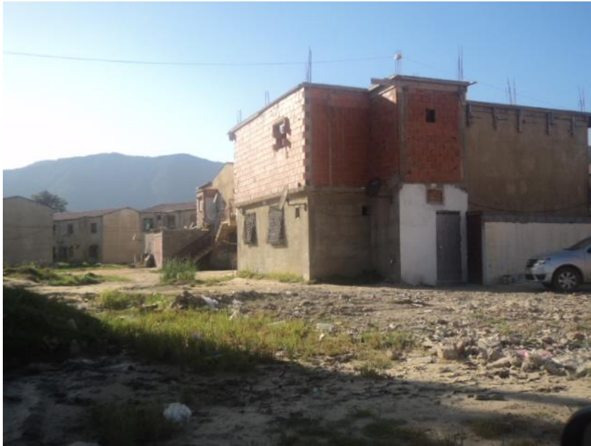
Figure 72 : Logement rural complètement transformé.
