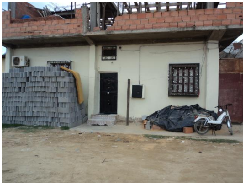
Figure 18 : Maison en cours de reconstruction en dur.
