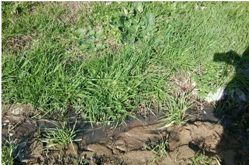
Figure 97: Egout à ciel ouvert.
