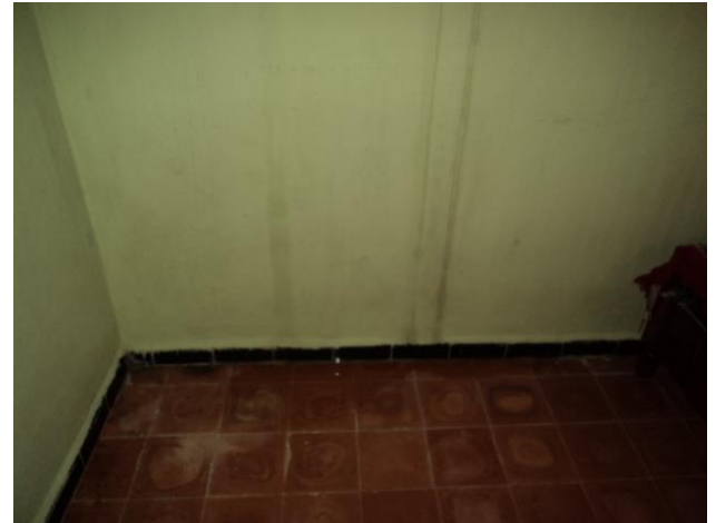
Figures 53, 54 : Infiltration d'eau.
