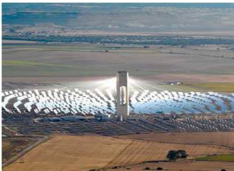
Figure 1.14 : Centrale à tour solaire [44]
